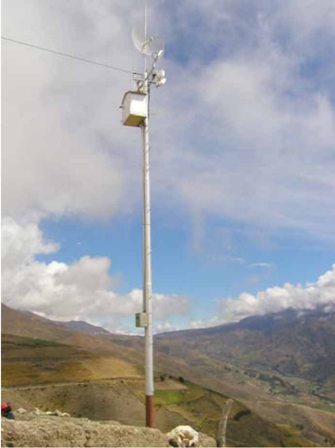
شكل 7.3: أحد الأشكال البسيطة للأبراج المدعومة ذاتياً.
