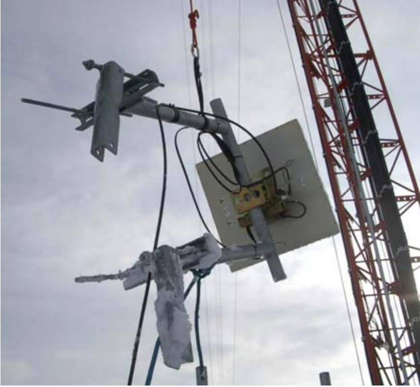
شكل 7.1: عملية رفع هوائي مركب على حامل إلى أعلى البرج.
